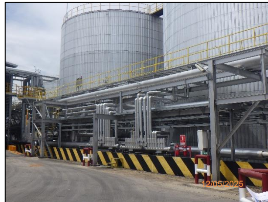
รูปที่ 2-3 การหุ้มระบบท่อด้วยฉนวนกันความร้อน
