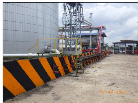
รูปที่ 2-21 กำแพงกันล้อมรอบถังเก็บแอสฟัลท์
