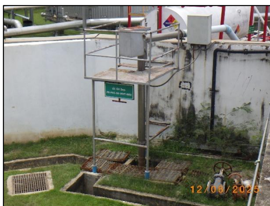
รูปที่ 2-9 บ่อดักน้ำมัน (Oil Separator)
