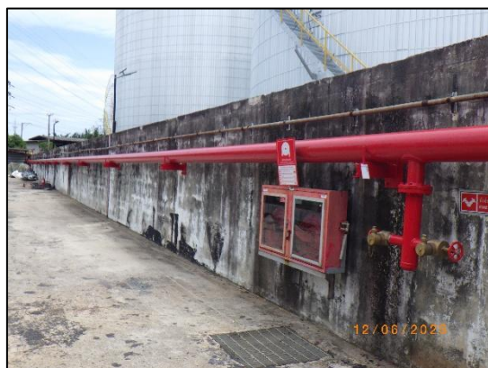
รูปที่ 2-21 กำแพงกันล้อมรอบถังเก็บแอสฟัลท์
